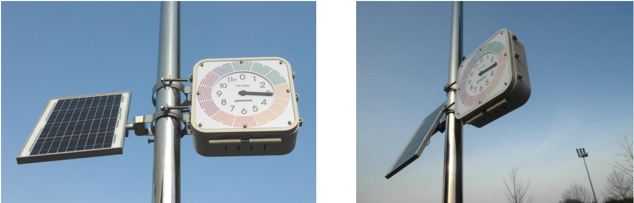
Fig 5. Actual Installation Example
